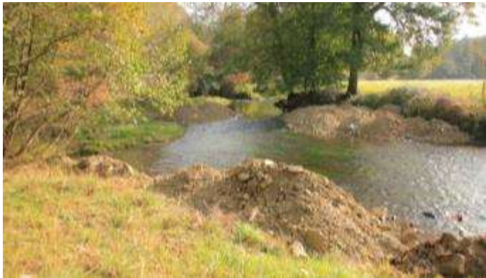
Figure 14: mise en place des banquettes minérales
