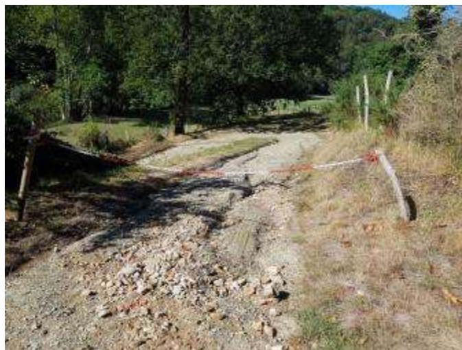
Figure 22: vue du chemin dégradé par les ruissellements
