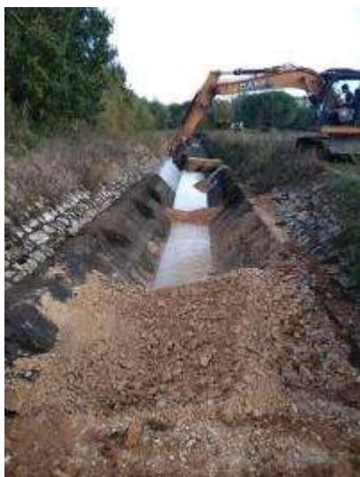
Figure 29: Réalisation de radiers à l'aide des matériaux des batardeaux
