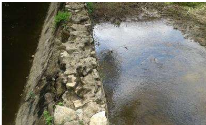
Figure 30: Infiltrations d'eau dans la digue aval
