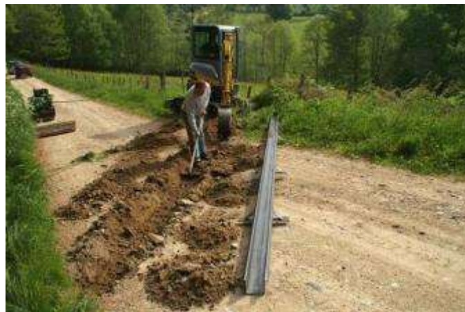
Figure 21: exemple de mise en place d'aco-drain
