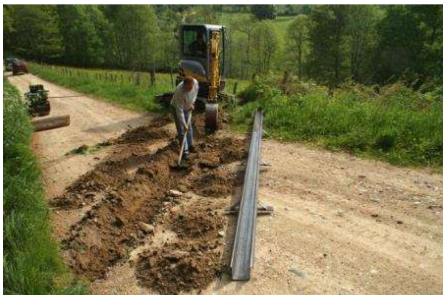
Figure 50: Exemple de mise en place d'aco-drain
